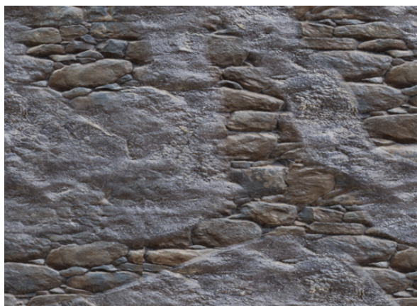
Рис. 2.48. Матеріал кам'яної кладки зі штукатуркою
