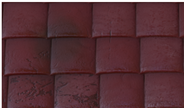
Рис. 2.81. Матеріал червоної покрівлі
